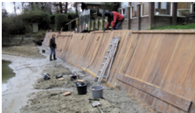
Hout heeft bij veel aannemers en hoveniers nog steeds de voorkeur. Mits het goede hardhout wordt gebruikt gaat het erg lang mee en het plaatsen van een houten beschoeiing is bekende techniek.
