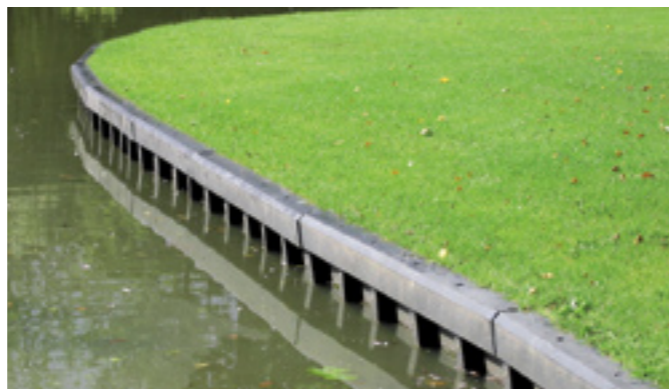
Een voorbeeld van een kunststof beschoeiing van Lankhorst. De grote vraag naar hout maakt ook het hout steeds duurder en ligt politiek steeds moeilijker. Per saldo is zeker voor de korte termijn een kunststof beschoeiing niet goedkoper dan een houten.
