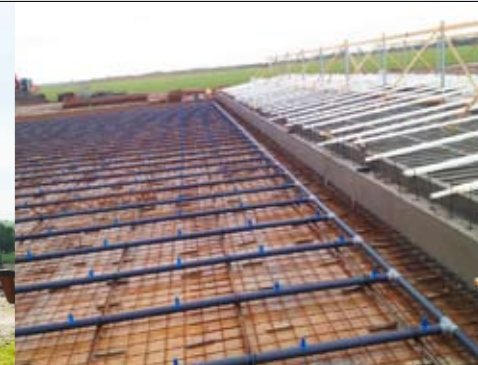
Een buizenstelsel belucht de bodem, het systeem is volledig in beton gestort
