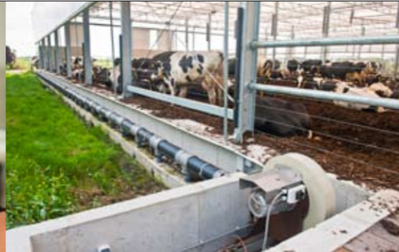
Ventilator blaast lucht in het buizenstelsel
