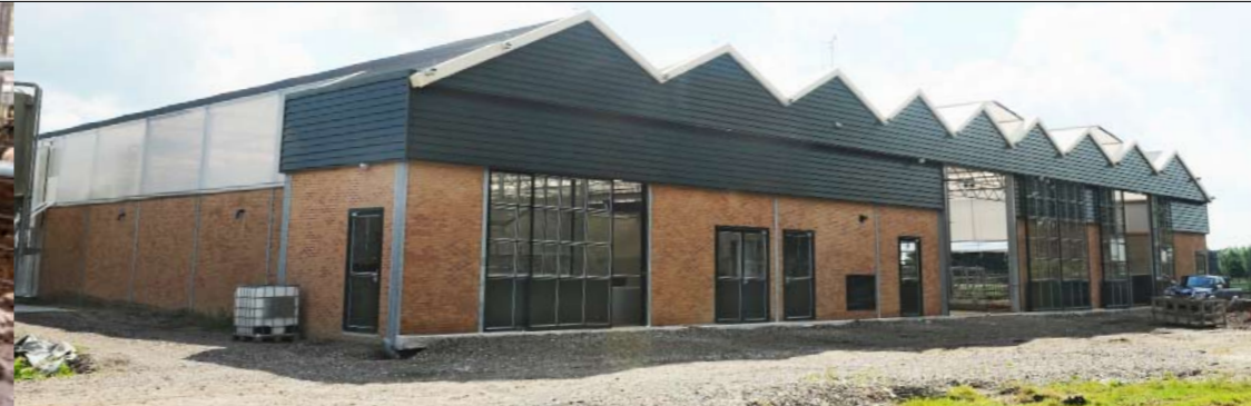
De buitenkant van de stal heeft de vorm van een tuinbouwkas, waardoor er veel daglicht is
