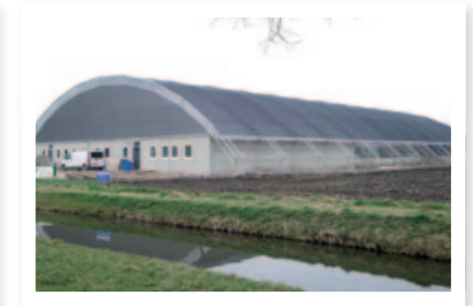
DE BOOGHAL HEEFT DANKZIJ DE SPANTVORM EEN ISOLERENDE LAAG TUSSEN PVC-FOLIE EN HET SCHADUWDOEK ER BOVEN. FOTO: BOOGHAL BV
