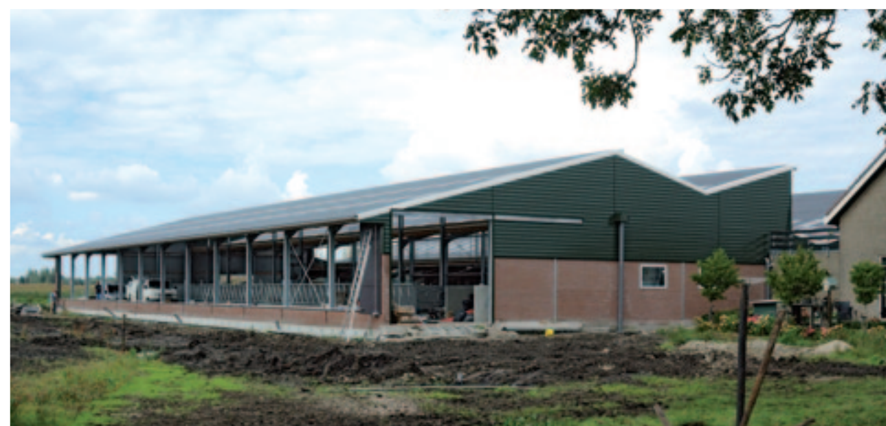
↑ EEN ITALIAANSE STAL HEEFT MEER LUCHTINLAAT EN MAAKT HET MOGELIJK BREDER TE BOUWEN VOOR GUNSTIGE LOOPLIJNEN.
