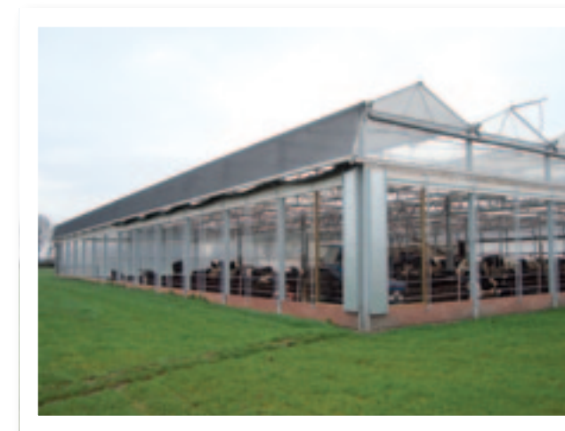
↑ GROTE VRIJLOOPSTAL ONDER EEN V-STAL BOVENBOUW. FOTO: WUR LIVESTOCK RESEARCH
