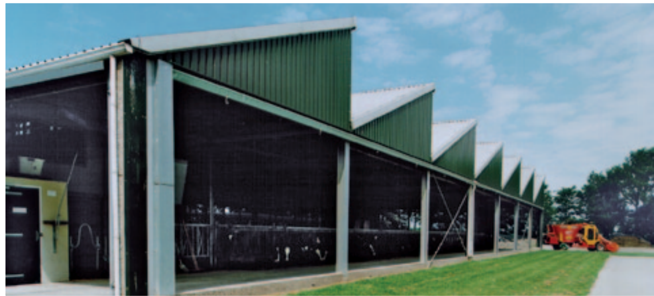
↑ DE HIGH-TECHSTAL VAN DE WAIBOERHOEVE HAD TIEN KEER ZOVEEL VENTILATIEOPPERVLAK ALS EEN VERGELIJKBARE ZADELDAKSTAL. FOTO: WUR LIVESTOCK RESEARCH
