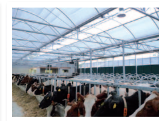
↑ WARMTE LUCHT ZIT TEGEN HET DAK EN IS METEEN WEG ALS DE KAP VAN DE SERRESTAL OPEN DRAAIT. FOTO: ID AGRO
