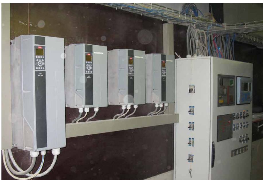
Frequentieregelaars die het toerental van de benodigde pompen regelen.
