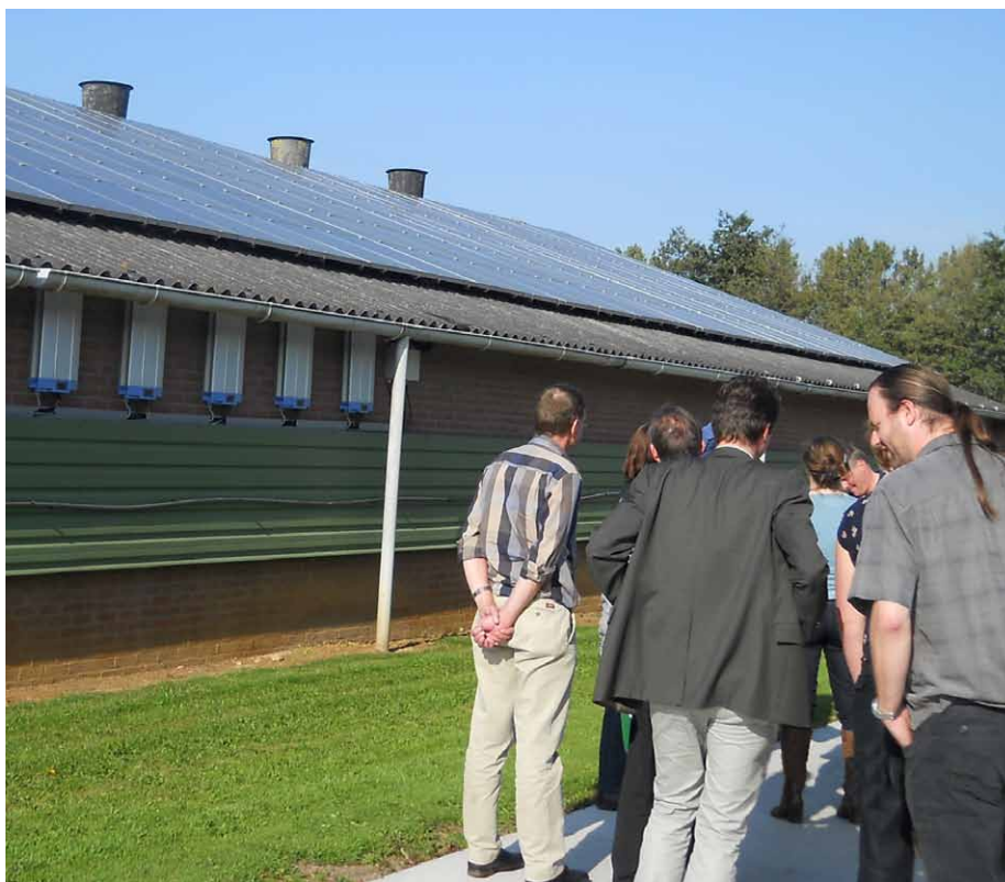
Zonnepanelen produceren met gemak 25 jaar stroom.
