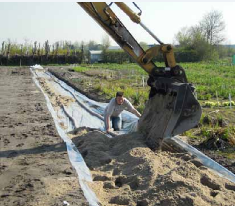
Aanleg zandbedden voor de praktijkproef bij vastplantenkweker Molter in Noordwijkerhout.
