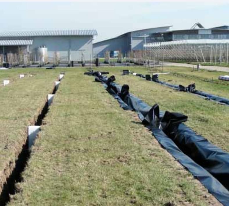
De aanleg van de verschillende systemen in het voorjaar van 2011.
