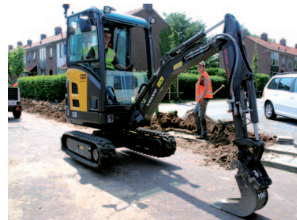
Minigravers werken veel in zand en dat kan tot onnodige slijtage leiden. Regelmatig schoonmaken hoort dan ook bij het normale onderhoud.
