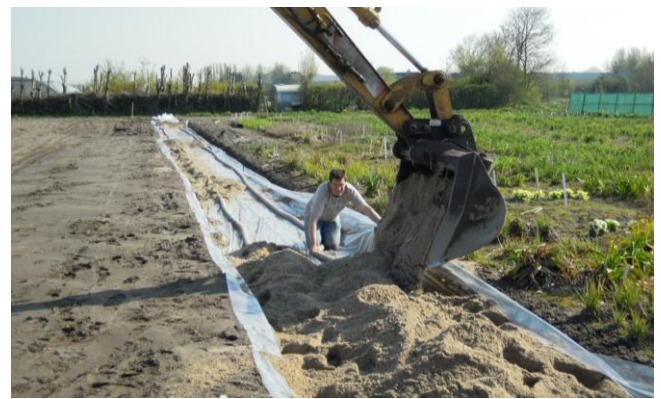
Aanleg substraatbedden, voorjaar 2011
