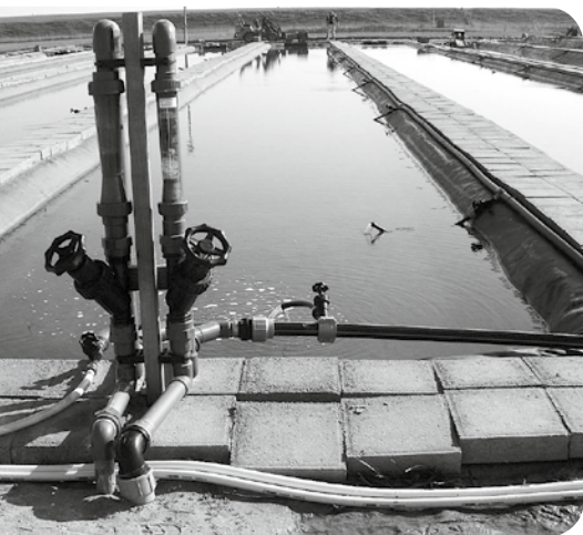
De schelpdierenvijvers met een kraan voor recirculatie en een andere kraan voor aanvoer van vers Oosterschelde water (Foto: Bram Boogaard).
