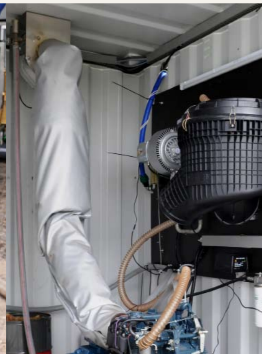
Gasblower stuurt gas naar de motor
