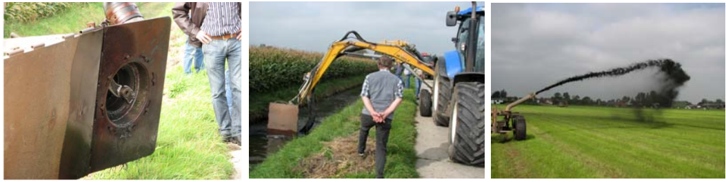
Foto's 4.4 De baggerpomp zuigt het materiaal uit de sloot en verspreidt een homogene laag bagger van 3 tot 4 cm dik over het grasland.
