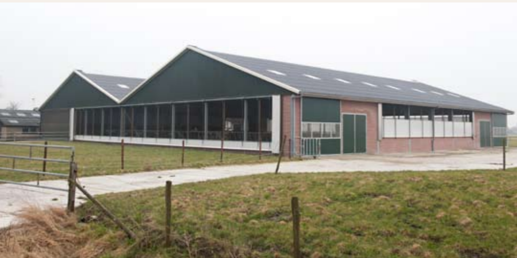
De nieuwe stal heeft een bijzondere dubbele kapconstructie en grote luchtinlaat
