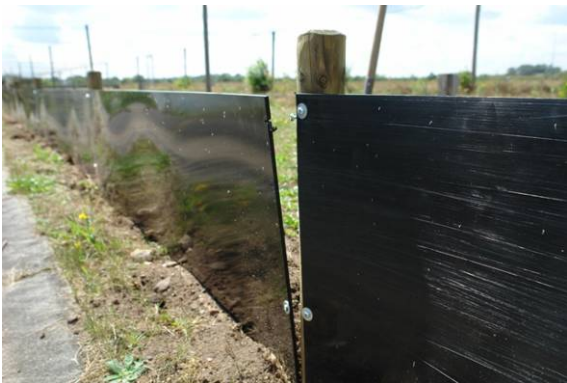
Links. Een voorbeeld van één van de ontstane openingen en rechts een uitgevoerde noodreparatie. Foto's: Fabrice Ottburg
