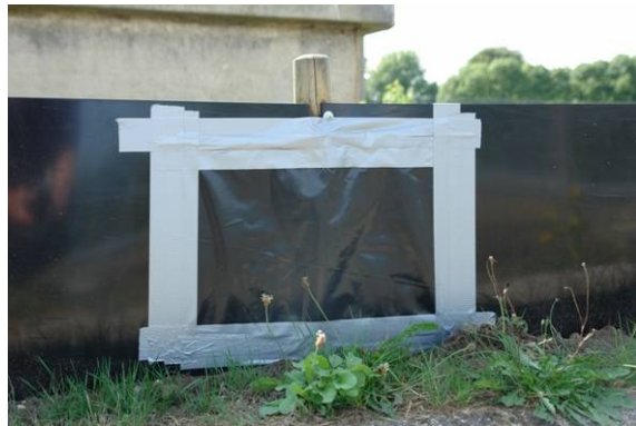
Links. Een voorbeeld van één van de ontstane openingen en rechts een uitgevoerde noodreparatie. Foto's: Fabrice Ottburg
