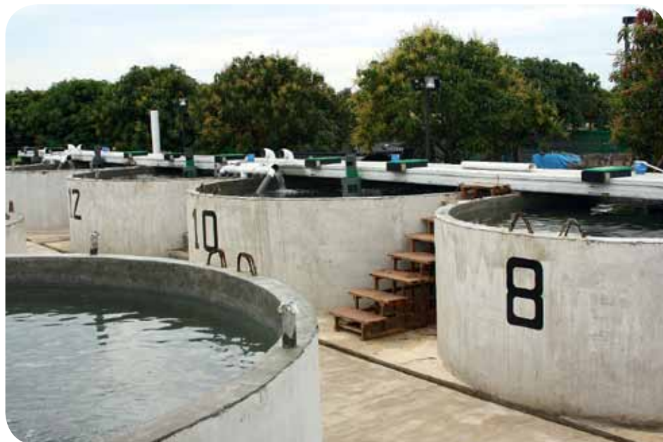
De tanks op de nursery.
