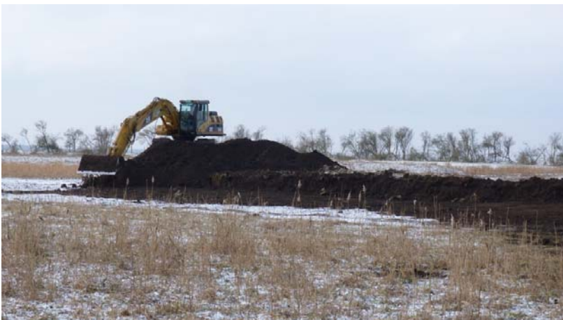
Aanleg van de schuilrichels
