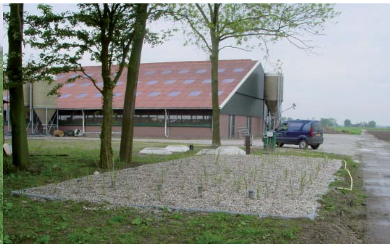
Helofytenfilter voor zuivering afspoelwater in de veehouderij (foto: Waterschap Zuiderzeeland)
