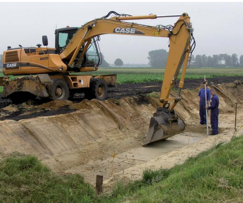
Aanleg moerasbufferstrook op Vredepeel. Meekoppeling met WB21 is goed mogelijk.
