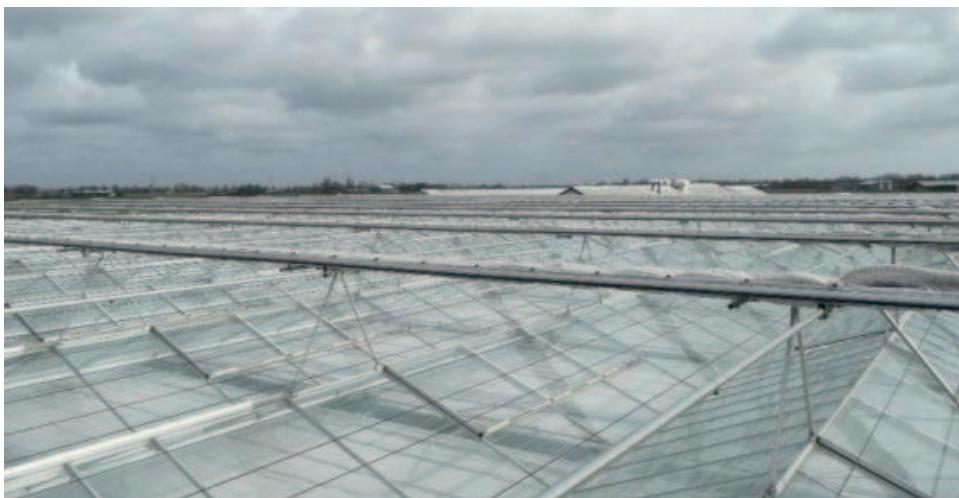
Figuur 13. Afdekkapjes boven het buitenscherm kunnen plaats bieden aan PV cellen (Foto van der Valk Systemen, Monster).
