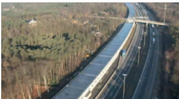
Figuur 8. Spoorwegoverkapping langs E19 van Breda naar Antwerpen waarop (Foto Solar Power Systems, www.sps.be ).
