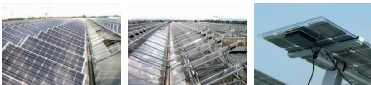
Figuur 12. Beweegbare zonnecelmodules op het kasdek (Foto's Van der Valk Solar Systems bv, Monster).
