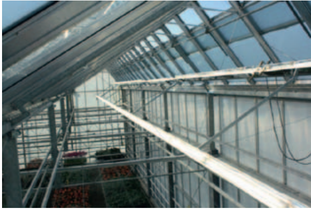
Figuur 16. Concentratie en absorptie van direct zonlicht via Fresnellenzen op twee collectoren in de DaglichtKas (IDC in Bleiswijk). De felle streep over de collector wordt veroorzaakt door de hoge intensiteit van het zonlicht in de brandlijn.
