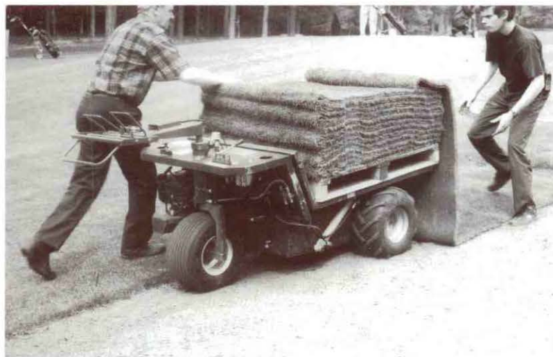
Met eigen personeel worden in 1 dag de 25 meter lange gras-slabs gelegd.
