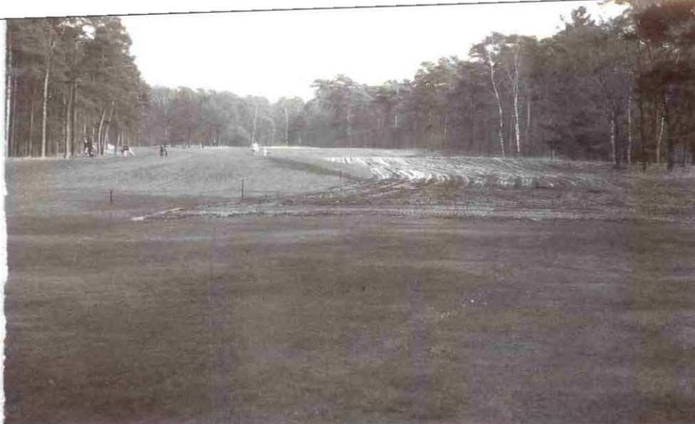
Circa 2500 m 2 fairway is omgeploegd en verrijkt met een 10 cm toplaag zwarte grond. Het op de foto linkergedeelte van de fairway is het vorige jaar gerenoveerd.
