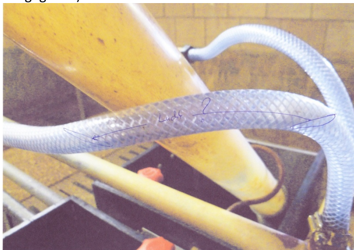
Na het drinken wordt een luchtbel in de waterleidingen gezogen.
