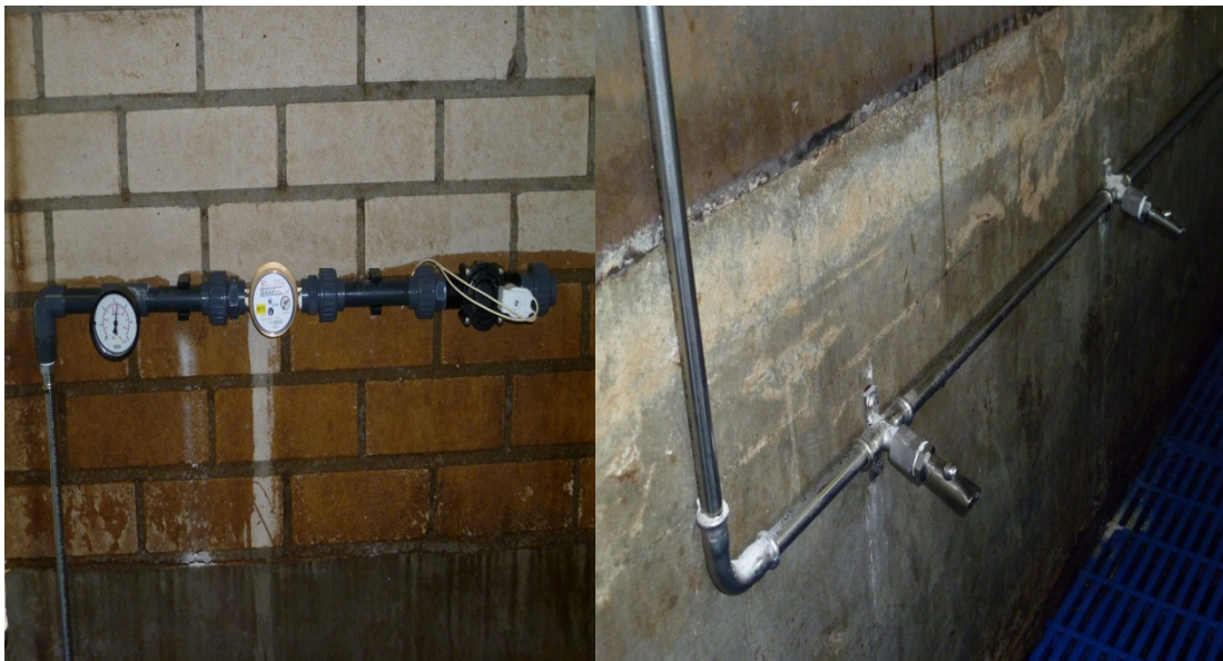
Links: Drukmeter, watermeter en afsluiter. Rechts: RVC-leidingsysteem met nippels met spuumogelijkheden.
