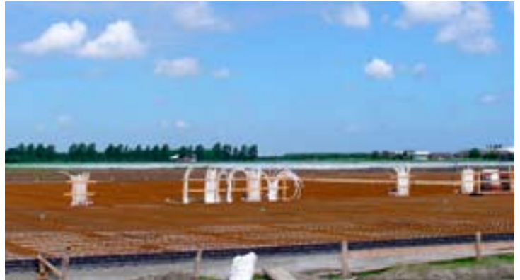
De aanleg van een warmtepompsysteem bij Aquaflow BV
