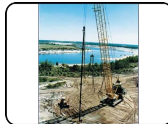
'Rütteldruckverdichtung'
