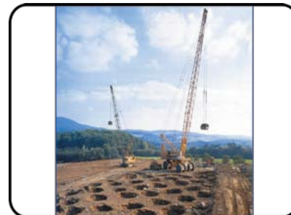
'Fallplattenverdichtung'
