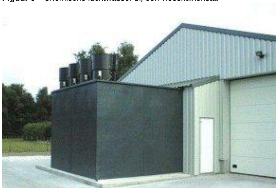
Figuur 5 Chemische luchtwasser bij een vleeskuikenstal
