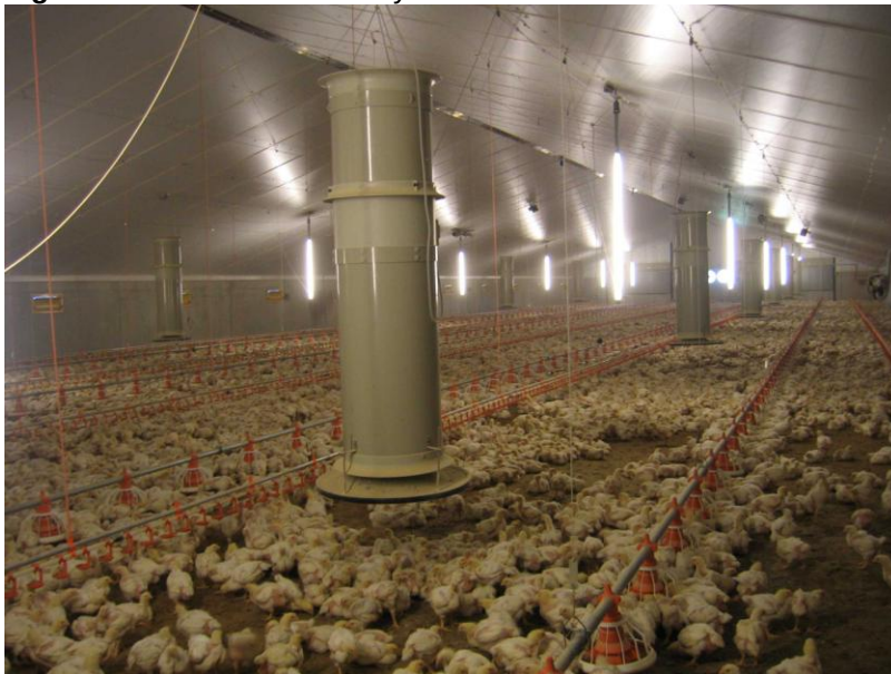
Figuur 4 Mixluchtventilatiesysteem in een vleeskuikenstal
