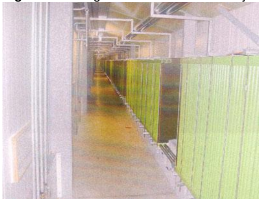
Figuur 7 Gang met warmtewisselaar bij het systeem met integrale luchtconditionering en -zuivering
