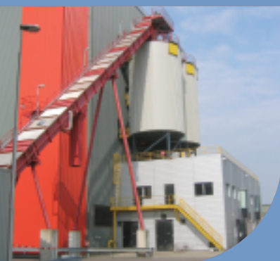
De bestaande bio-energiecentrale in Cuijk; nog steeds de grootste van ons land
