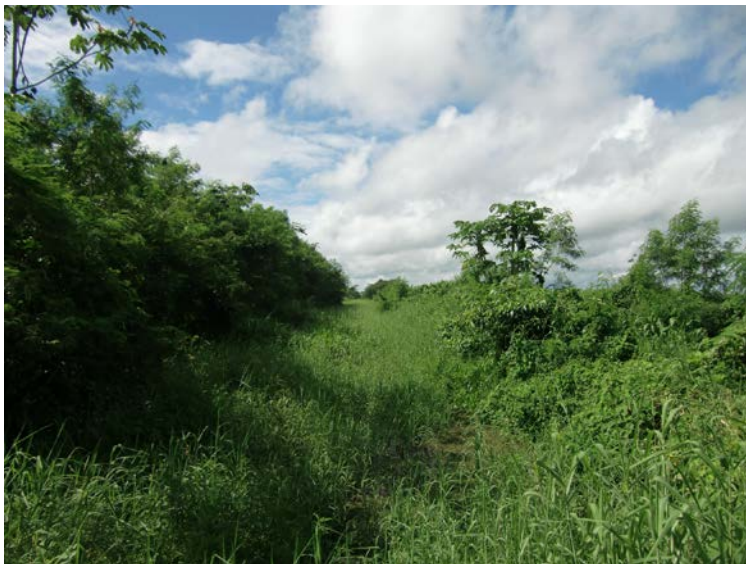
Foto 3.3: Slecht kanaal onderhoud door de landbouwer
