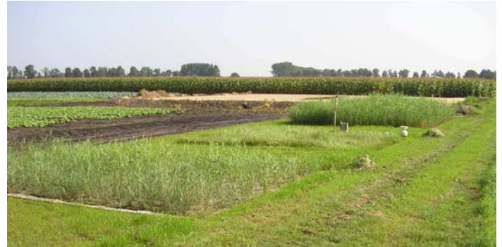
Figuur 2. Zuiveringsmoerassen met op de achtergrond de wateropslag.
