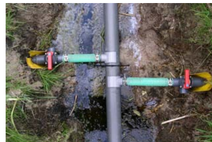
Figuur 3. Aansluiting drains op verzamelrain. Op elke drain zit een kraan waarmee gekozen kan worden voor opvang van water of directe afvoer naar de sloot.
