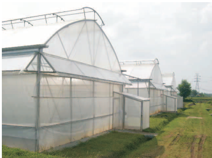
Figuur 1. Schoorsteenventilatie zorgt voor een voldoende koel kasklimaat in de tropen.
