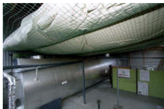
Het gas wordt opgeslagen in een zak, opgehangen boven de mestvergistingstank.
