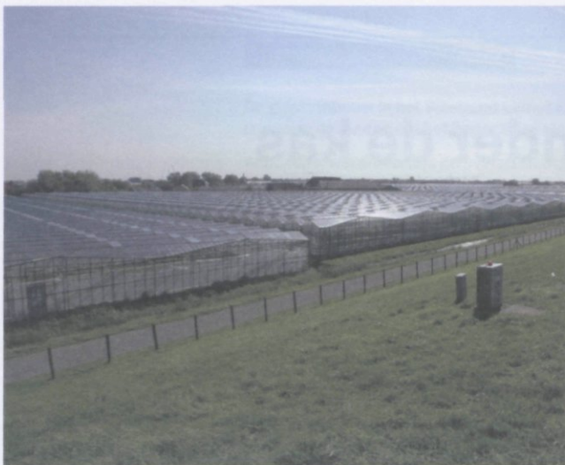
Aanleg waterbergingskelder onder de kas van Firma L.G. Vreugdenhil.
