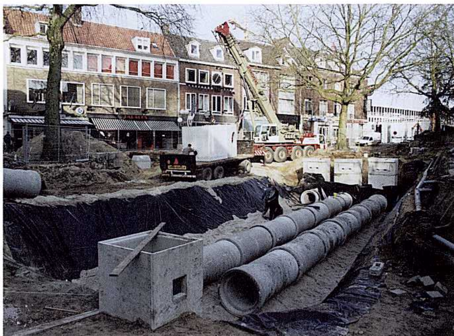
Figuur 5.2 De herinrichting van het Koningsplein in het centrum van Nijmegen, maart 1999. De regenwaterbassins die de bedriegertjes voeden worden aangelegd (foto: Niek Antonise).
