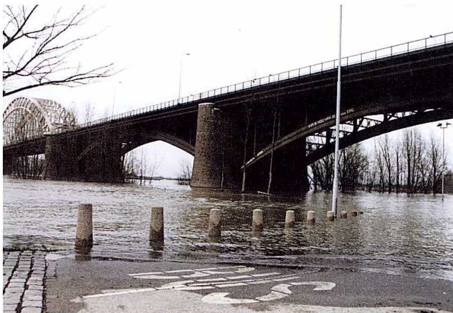
Figuur 1.4 Nijmegen, stad aan de Waal. Bij hoge rivierwaterstanden kan schade optreden. Klimaatsverandering maakt het beleid "vasthouden, bergen en dan pas afvoeren" noodzakelijk (foto: Irma Sanders).
