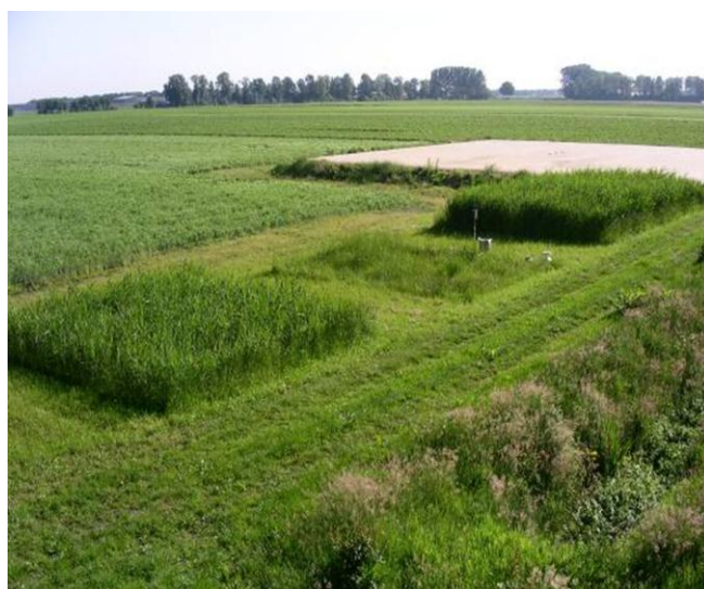
Zuiveringsmoerassen met wateropslag op PPO-proefbedrijf Vredepeel in de zomer. Vooraan de drie zuiveringsmoerassen, achteraan de wateropslag.
