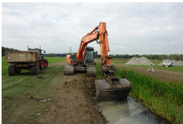
Links. Tijdens aanlegfase van de natuurvriendelijke oever in de Bieslandse Bovenpolder. Rechts. Resultaat na aanleg. Goed te zien zijn de oorspronkelijke slootranden met daarop de oevervegetatie.
