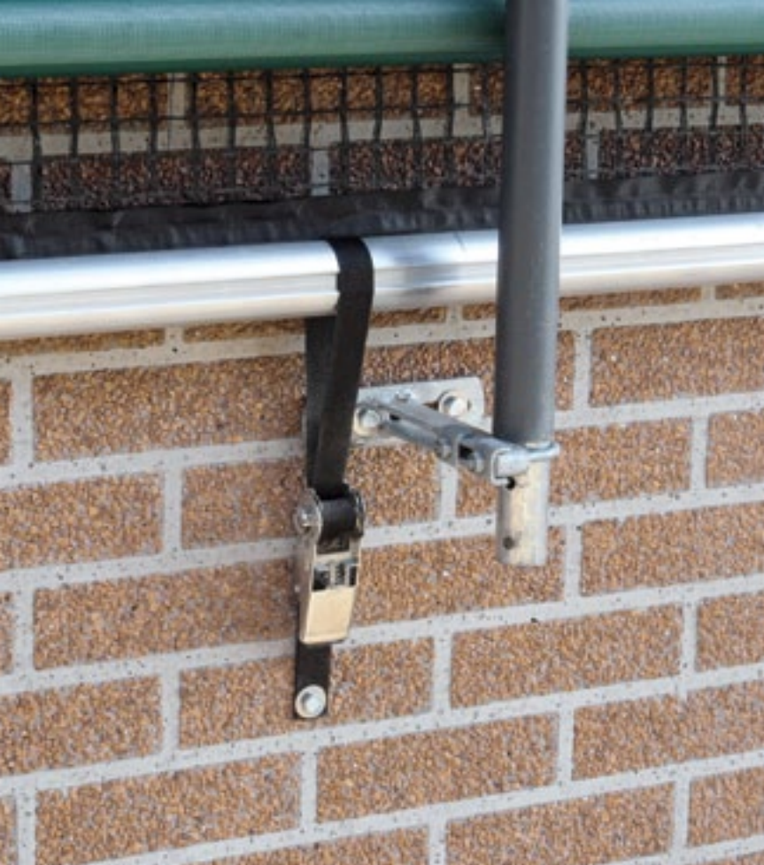
Hier zijn speciale spanbanden aangebracht om het gaas strak te houden.
