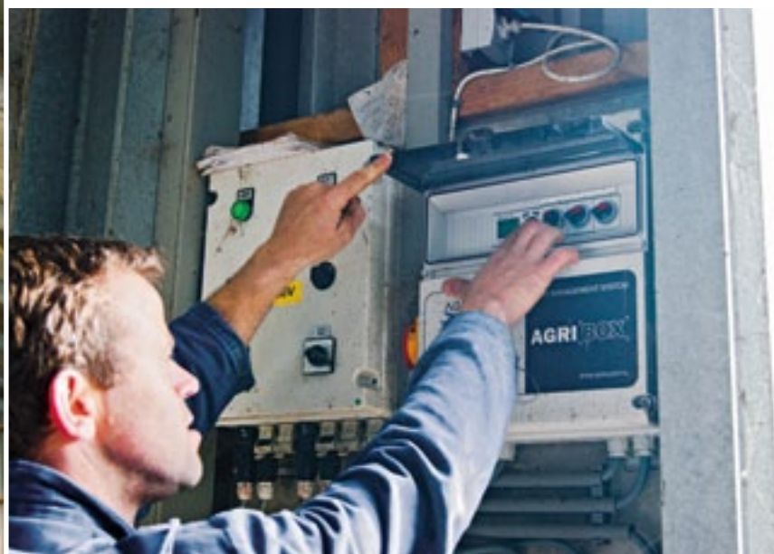
Om 21.00 uur schakelt het systeem bij Gorter automatisch over op de tl-verlichting. Om 5.00 uur gaan de metaalhalidelampen weer aan.
