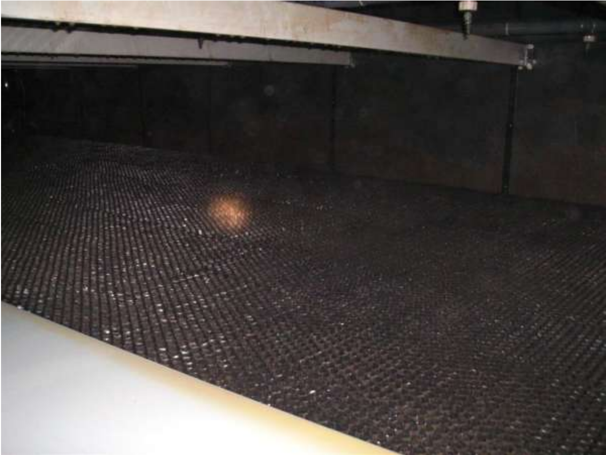
Figuur B11 Bovenaanzicht van het pakkingsmateriaal (sproeiers zijn uitgeschakeld) van de experimentele gecombineerde wasser op het varkensbedrijf bij pilot 4
