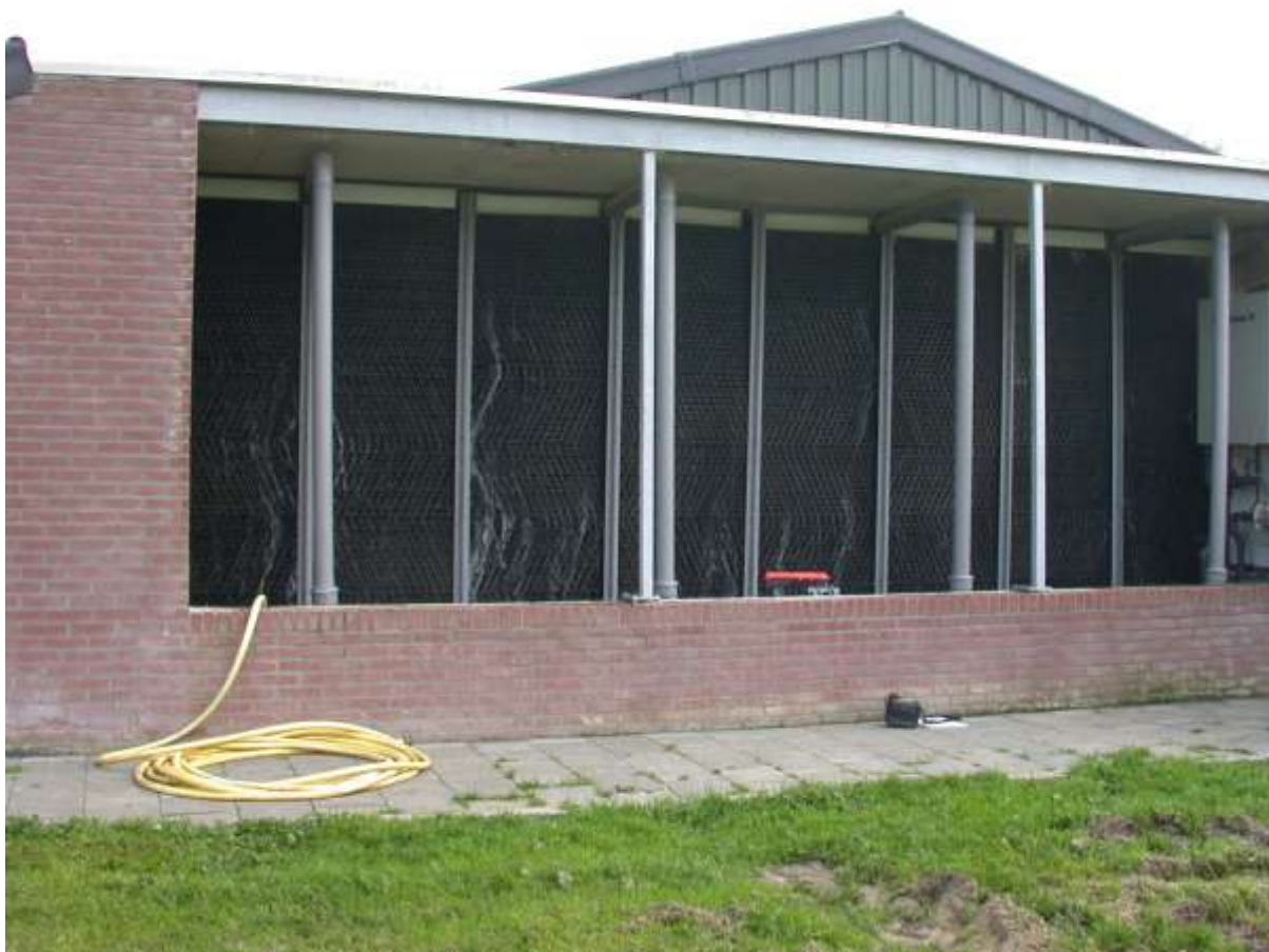
Figuur B5 Buitenaanzicht van de experimentele gecombineerde wasser op het pluimveebedrijf bij pilot 1
