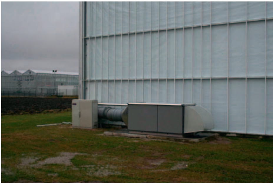
Figuur 1. De luchtbehandelingkast buiten de kas om lucht aan te zuigen voor gecontroleerde ventilatie. In de luchtbehandelingkast zit een ventilator en een warmtewisselaar.
