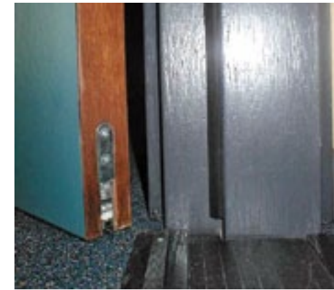
▲ Een valdorpel zorgt voor een stofdichte afdichting tussen werkplek en kantinegedeelte
