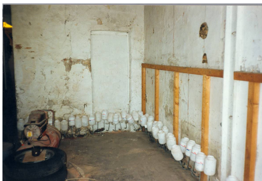
Figuur 3.16: Injecteren van muur onder hydrostatische druk
