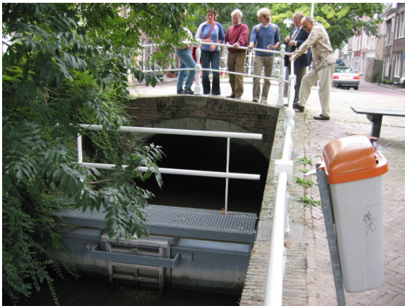
Figuur 6.3: Tijdelijke afsluitconstructie bij de Schie
