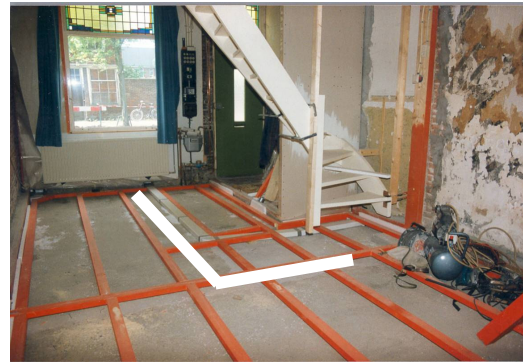
Figuur 3.19: Aanleg van vloerventilatie
