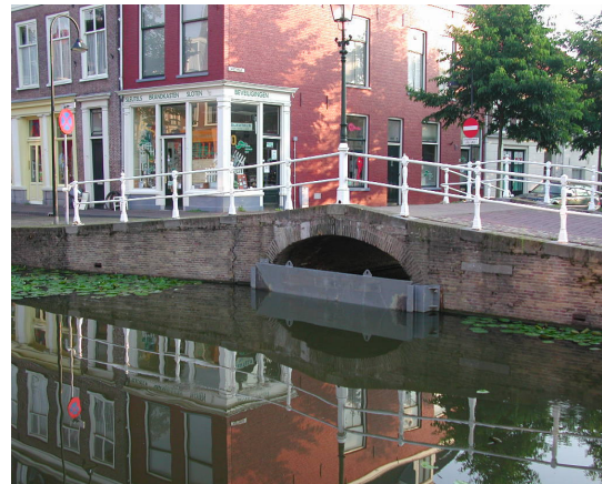
Figuur 6.4: Tijdelijke afsluitconstructie Rietveld
