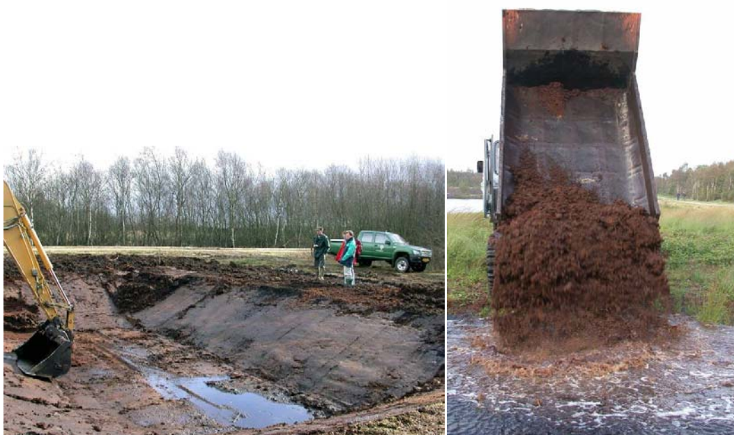
Figuur 5.3: In februari 2004 zijn in het Meerstalblok (Bargerveen) vijf zwartveenputten gegraven van 5 bij 10 meter (links) waar in september 2004 witveen is ingebracht (rechts).
