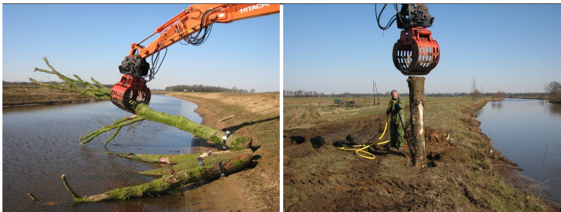
Figuur 7.2 Plaatsen van een boom met mobiele kraan (links) plaatsen van ankerstam met spuitlans en kraan (rechts)
