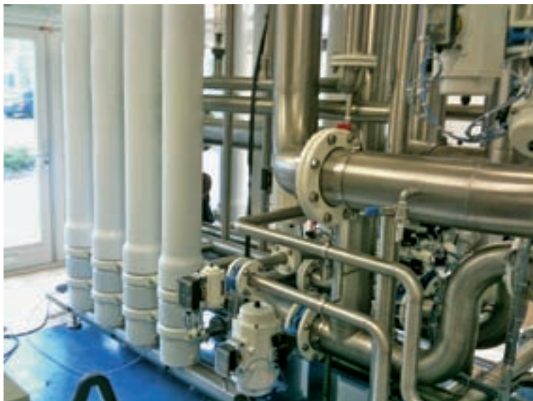
Figuur 9: Membraanskid
