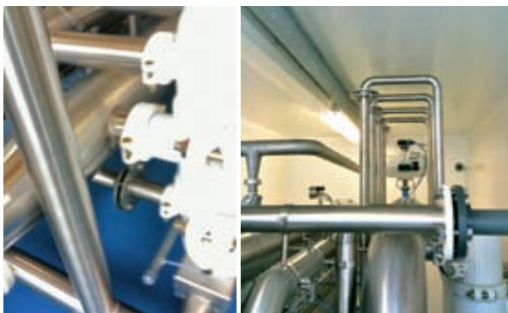
Figuur 11: Luchtinjectiesysteem; links luchtinjectie onder, rechts boven
