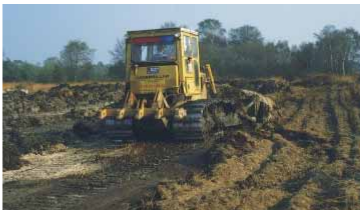
Figuur 1.2 Effectgericht beleid: Beheerders van zeer gevoelige natuur laten de bodemlaag, die teveel stikstof bevat, afschrapen, opdat de oorspronkelijke vegetatie zich op een voedselarme bodem kan herstellen
