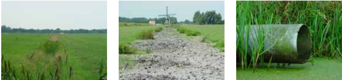
Vlnr: Het dichtgroeien van de sloot. Dempen van sloten. Duikerbuizen die boven de waterspiegel liggen, waardoor vissen zich niet van A naar B kunnen verplaatsen
