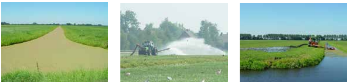
Vlnr: Verrijking (eutrofiëring) van een veenweidesloot. Watergebruik bij warme zomers en een voorbeeld van een verkeerde rijrichting tijdens het baggeren van open naar dicht (in plaats van omgekeerd)
