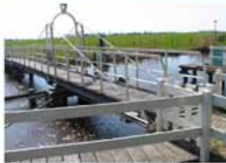
Draaibrug over de havenmonding
