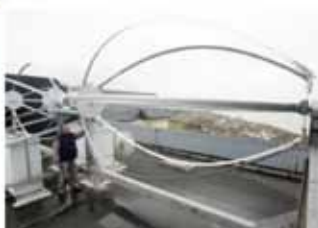
Horizontale windmolen op een gebouw
