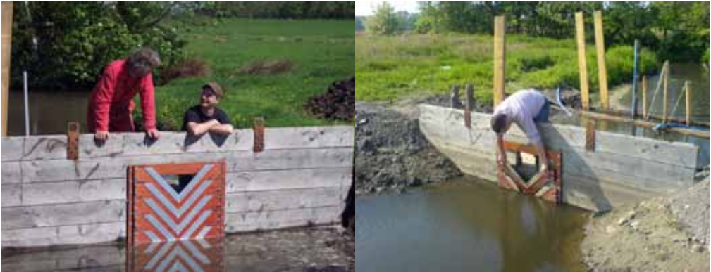
Figuur 3: Plaatsing van het meetschot waarbij de afzonderlijke V-notch segmenten nog zichtbaar zijn (links); verwijderen van een V-notch segment (rechts).
