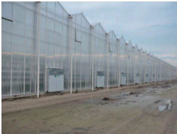
Figuur 16. Aanzicht kopgevel met luchtbehandelingskasten en gevelramen. Bron: Cogas Zuid.
