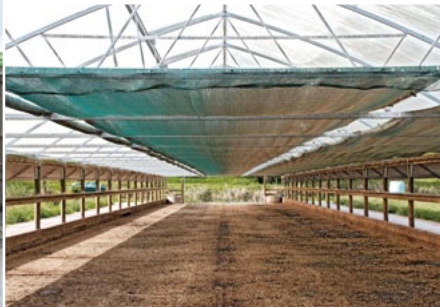
De Herd Home met doorzichtig plastic dak staat boven een roostervloer met mestput. De koeien worden aan de buitenkant van de stal bijgevoerd.
