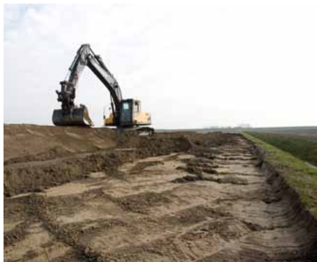
◀ Het omdijken van de dertig hectare was de laatste klus. Hiervoor is de grond in een strook van maximaal vijf meter breed en veertig centimeter diep afgegraven. Het is Wieringa's visitekaartje voor een volgend project.
