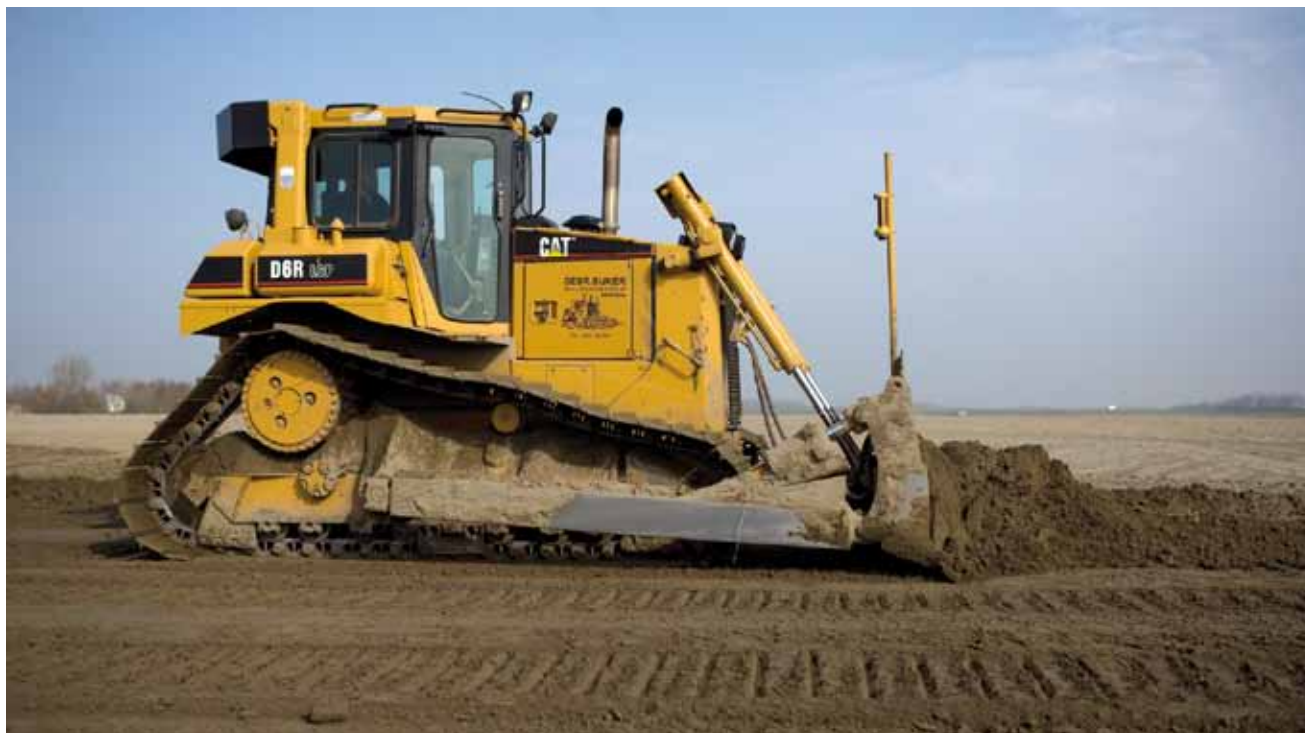
◀ Het grove egaliseriewerk is uitgevoerd door Gebr. Bijker Bulldozerbedrijf. Jan Bijker zat zelf op de D6R, die ook op de laser van Wieringa werkt.
