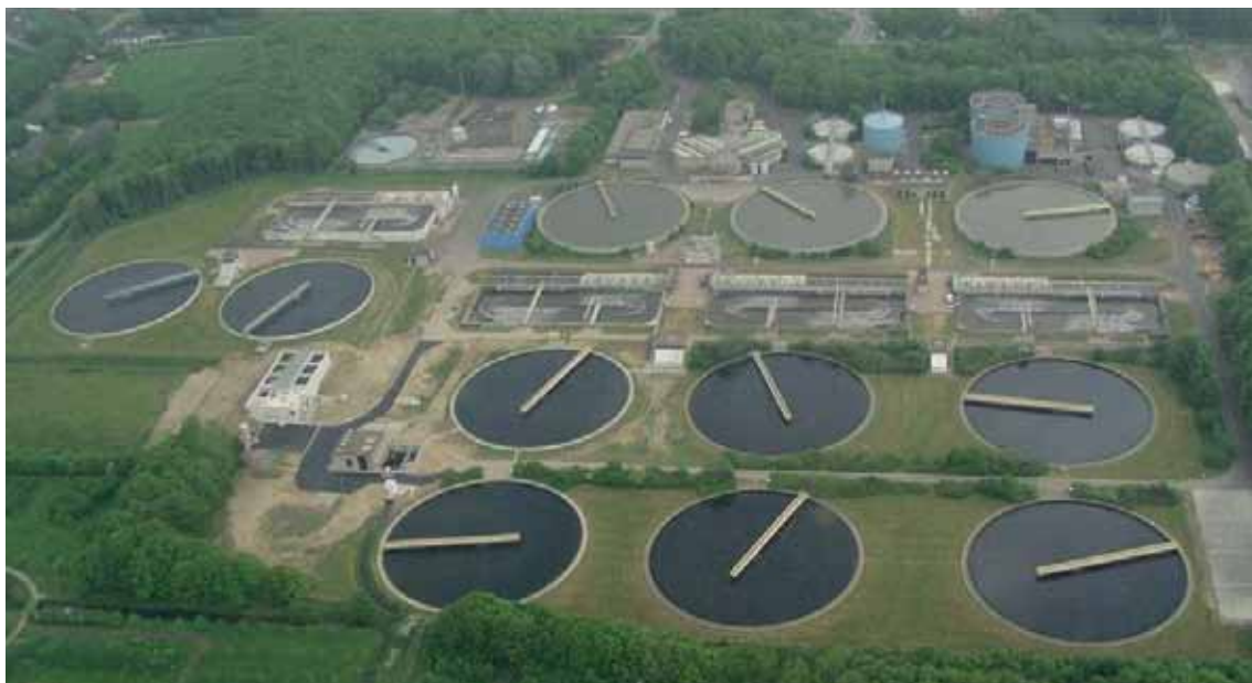
AFBEELDING 21 LUCHTFOTO VAN DE RWZI NIJMEGEN
