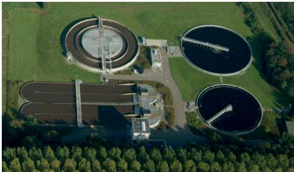
LUCHTFOTO VAN DE RWZI GOEDEREDEE
