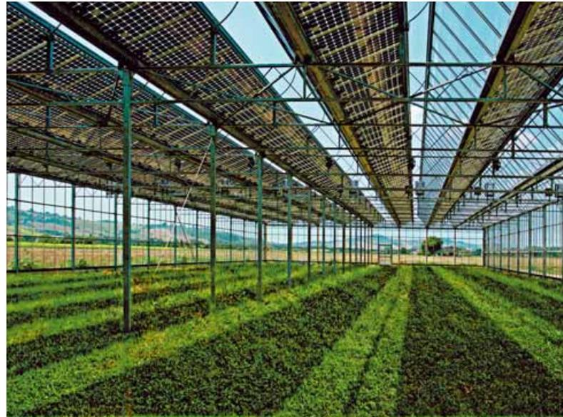
**Foto 2** L'installazione di pannelli fotovoltaici su una serra comporta un costo, in termini di minore raccolto, stimabile in circa 10 centesimi di euro per ogni kWh elettrico prodotto
